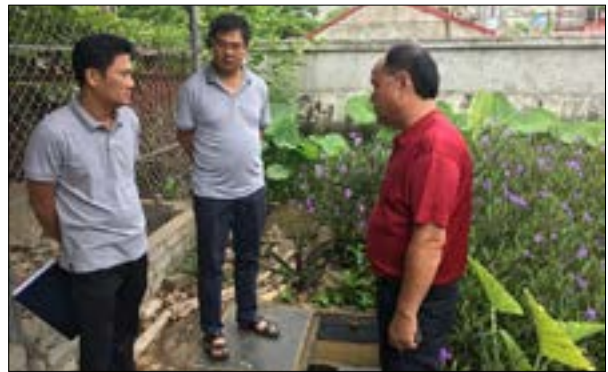
▲ Khu vực hệ thống xử lý nước thải y tế Bệnh viện Đa khoa huyện Phù Yên
